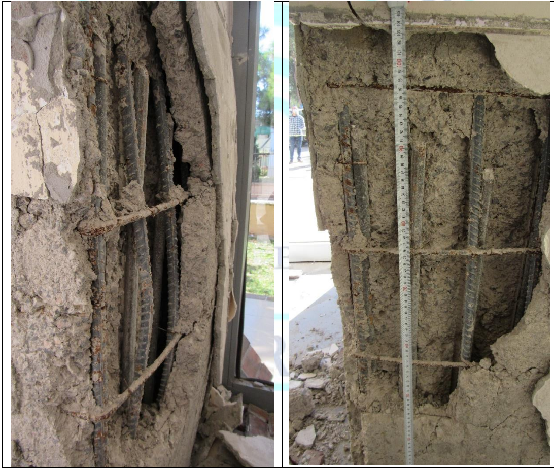
Şekil 9. Etriye Sıklaştırılmaması ve Çiroz Kullanılmaması Örnek Fotoğraflar
