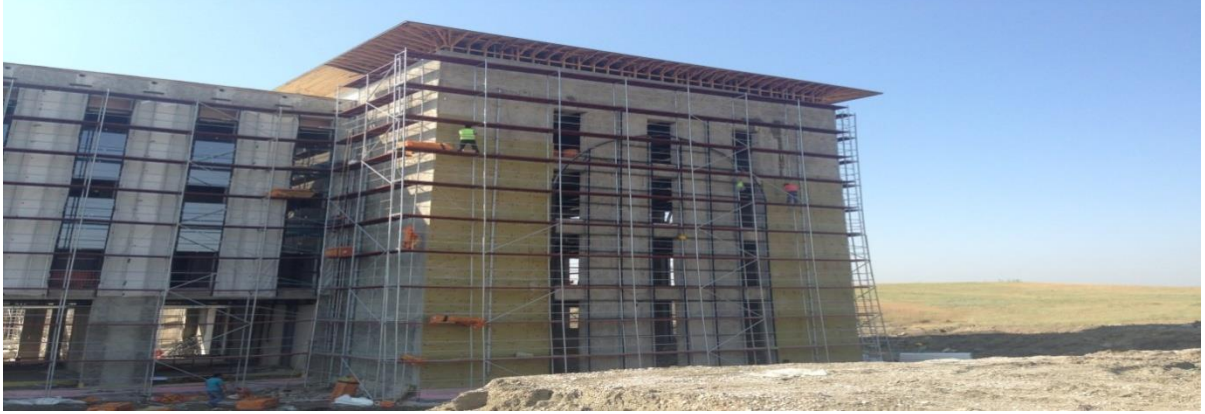
İTBF A BLOK DIŞ CEPHE ISI İZOLASYON ÇALIŞMASI
