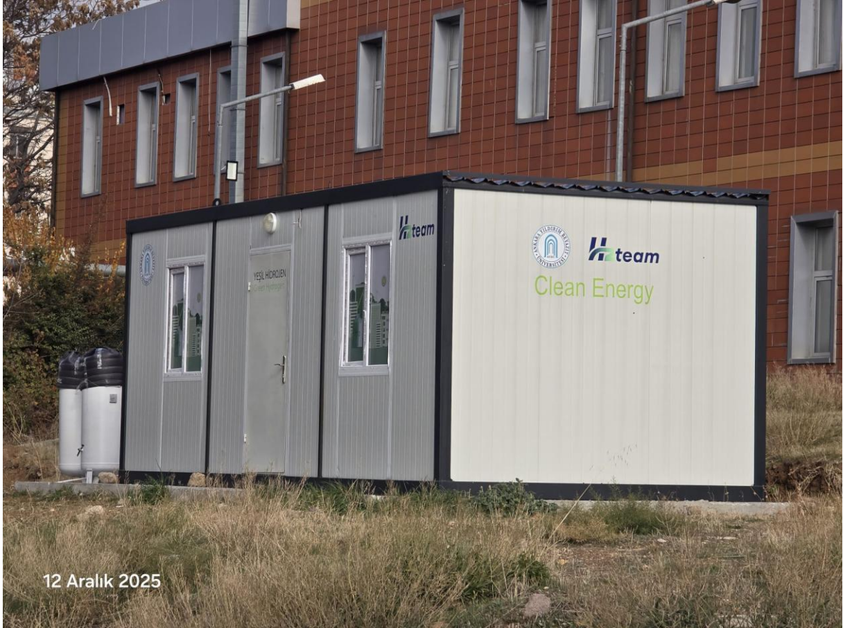
Şekil 4 Konteyner tipi PEM elektrolizör sistemi görünümü
